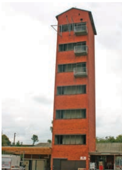
Brandtårnet bruges til brandøvelser, men i lige så høj grad til at tørre brandslanger
